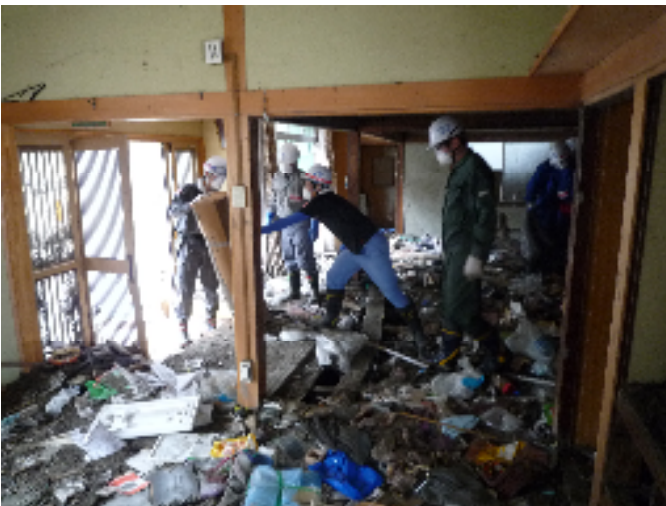
▲被災した住居からの瓦礫等の撤去作業状況(4日目)
