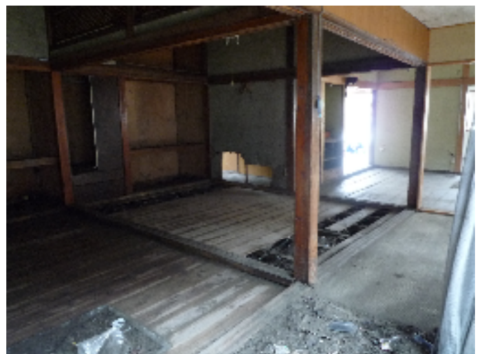
▲作業終了後の屋内
